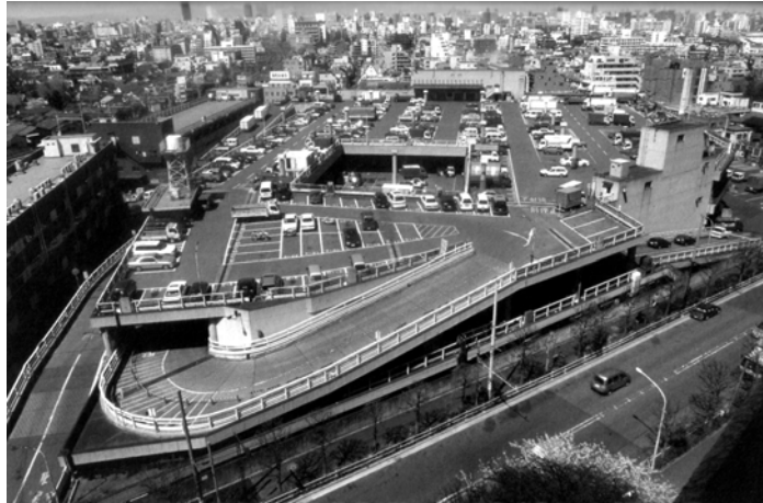
Vegetable Town, Tokyo : Ensemble formé d'un marché aux légumes et de boutiques associées. L'ensemble est couvert de parking, placés en continuité de la voirie par des rampes.
